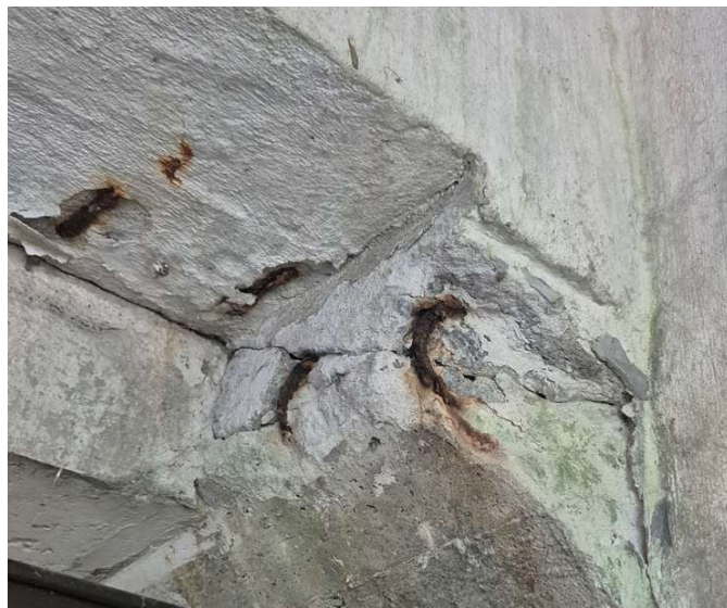
Zdj.8 Spękania i uszkodzenia otulenia w części galerii
