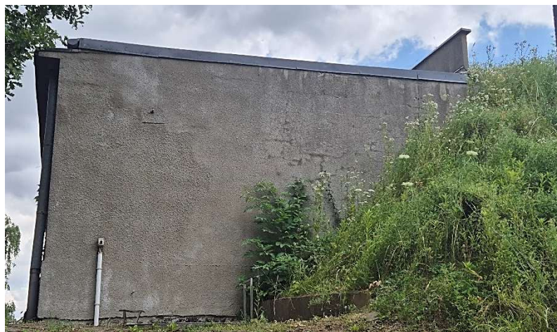
Zdj. 2 Elewacja wschodnia budynku z lat 80 XX w. Widoczny ściąg i niewielkie spękania.
