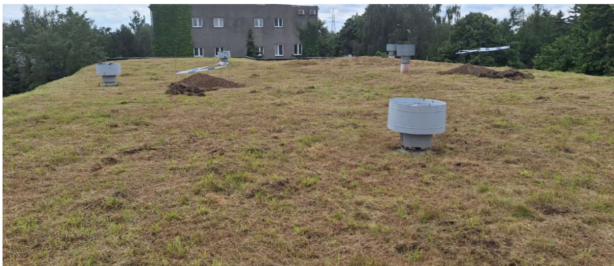
Zdj.9 Nasyp gruntu na dachu torów osadników, widoczna wentylacja.
