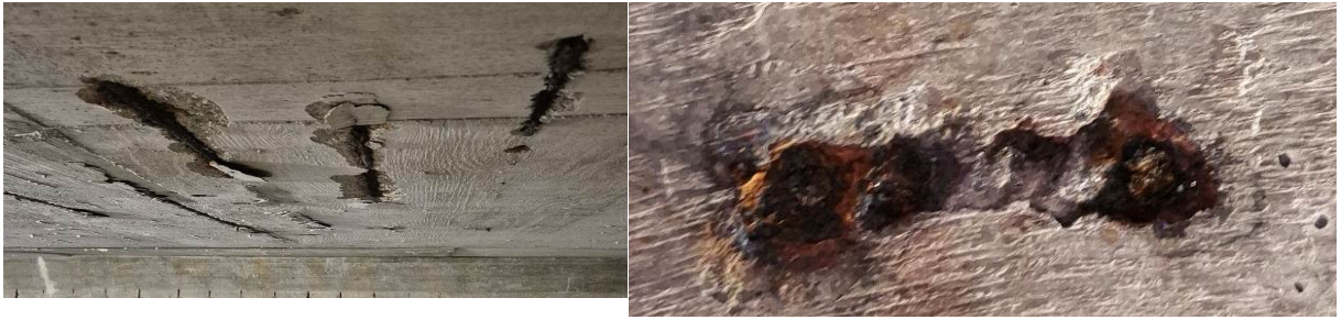
Zdj. 5 Strop z widocznym zbrojeniem i uszkodzeniami otuliny betonowej, posunięta korozja zbrojenia
