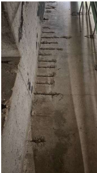
Zdj. 2 Stan techniczny pomostu wzdłuż torów. Również utrata otulenia zbrojenia przy ścianie.
